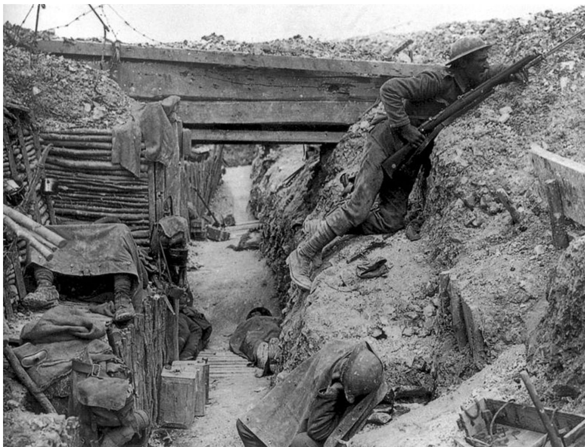
Trinchera británica en el frente occidental. Le Somme
